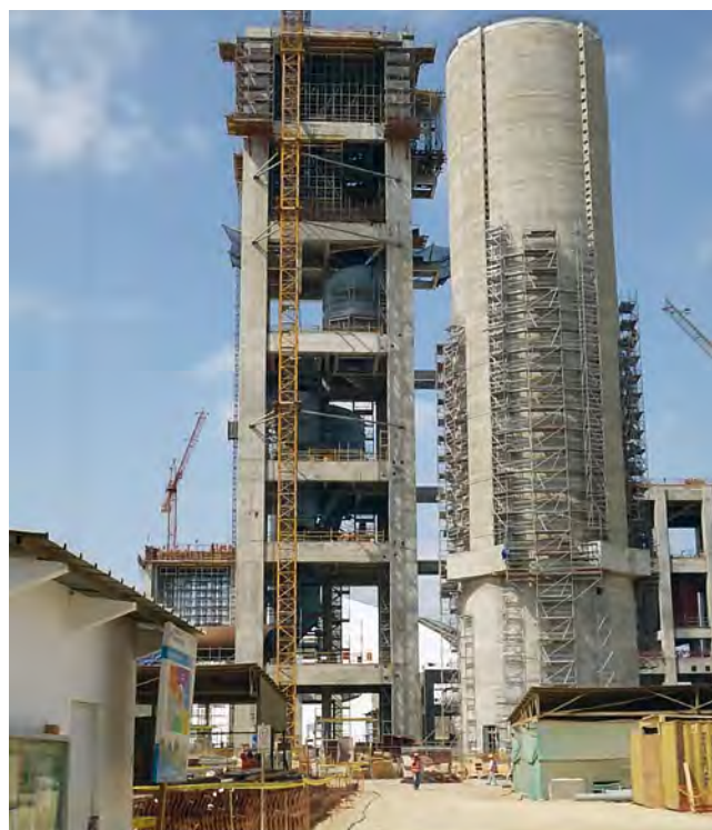
Schodnia BRIO o wysokości 75 metrów
