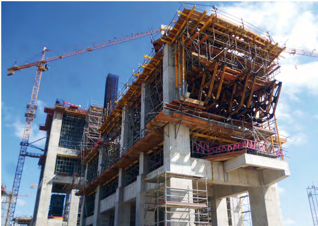
Kratownice MK zastosowane jako deskowanie krawędziowe stropu budynku o wysokości 127,55 m
